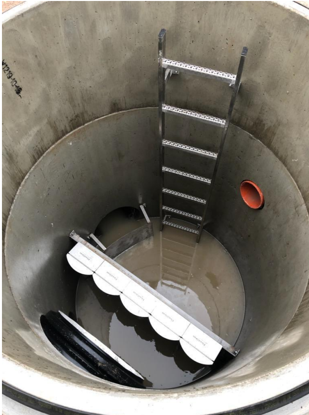
Figur 8. Exempel på filterkassett för dagvattenrening. Bilder hämtade från Flexicleans hemsida 2022-11-07.
