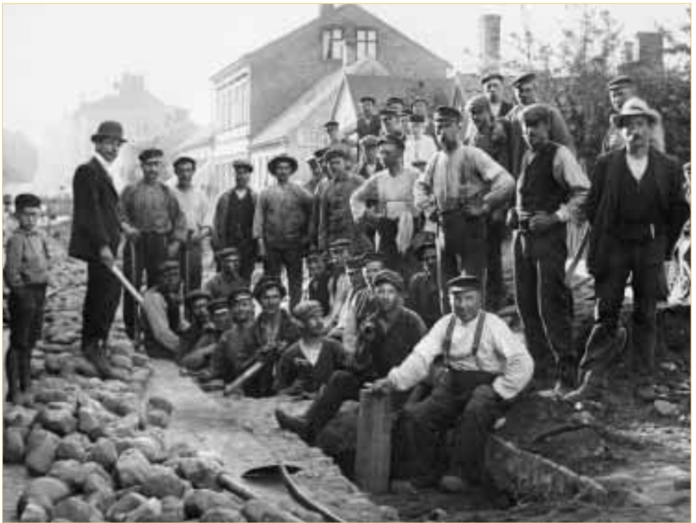
Gatuarbete på Östergatan i slutet av 1800-talet. Det var skillnad på folk och folk. Arbetarna bär keps och arbetsledaren plummonstop. Men huvudbonad har naturligtvis alla.
