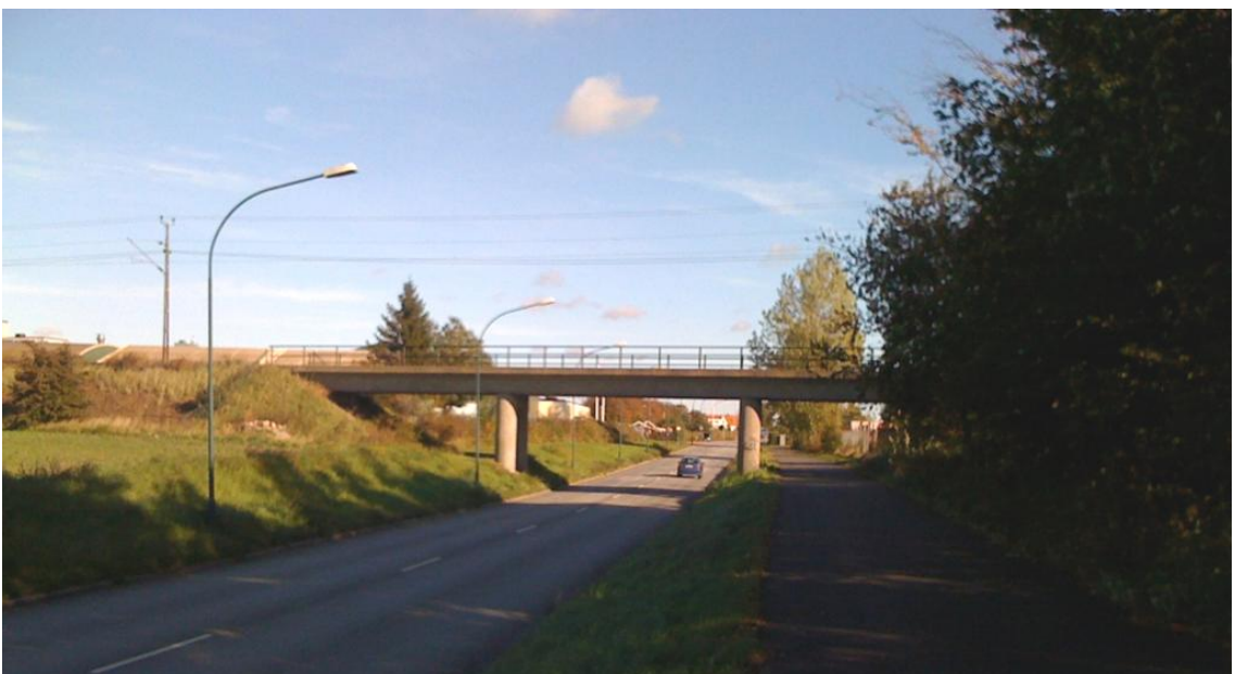
Figur 4. Höjdförhållandena vid järnvägsbron gör det svårt att anlägga en busshållplats omedelbart intill järnvägen. Vy från väster.
